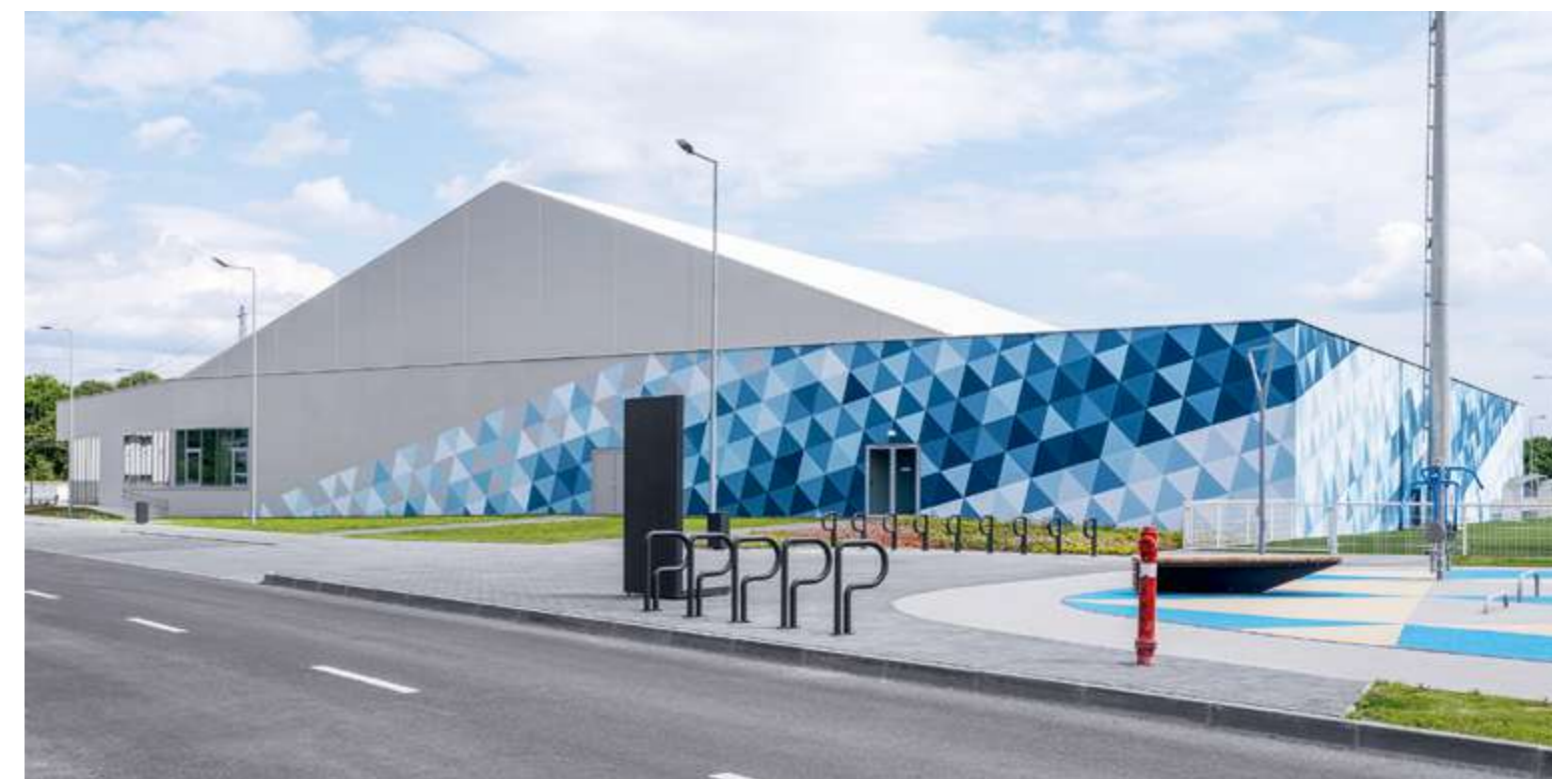
Az edzőcsarnok ponyvafedésű sátra két kézilabdapályát rejt. Ehhez közvetlenül kapcsolódik egy földszintes kiszolgálóépület a 6 pástos gyakorló vívóteremmel.
