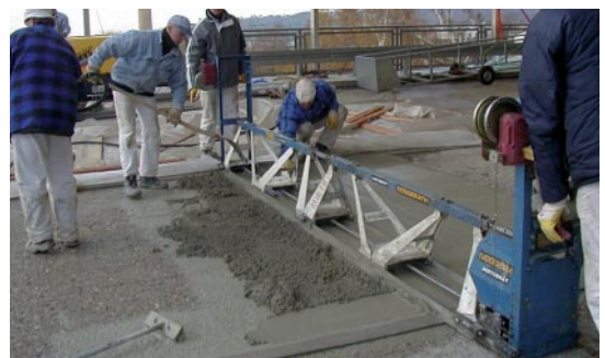
3. Nafufill KM 130 vagy Nafufill KM 180 betonjavító rendszer beépítése.
