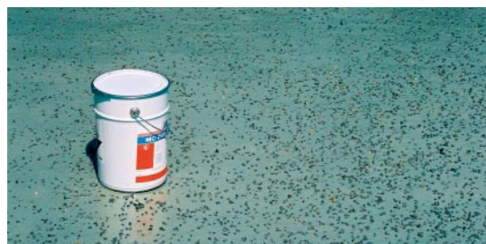
4. Kötőréteg felvitele MC-DUR 2295 LM-mel, zúzalék behintéssel.
