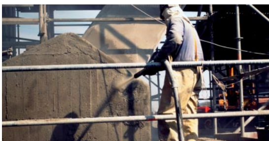
1. Betonpótlás részfelületeken.
