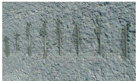
1. Szabadon lévő vasalat korrózióvédelme: Zentrifix KMH.
