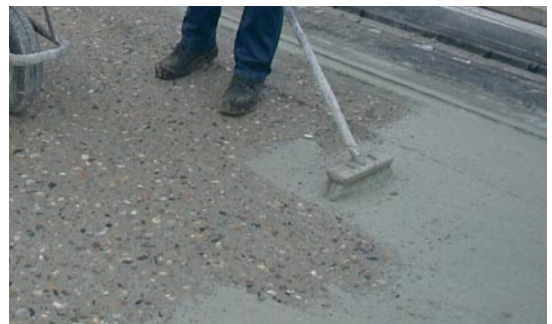
2. Tapadóhíd felvitele: Zentrifix KMH.
