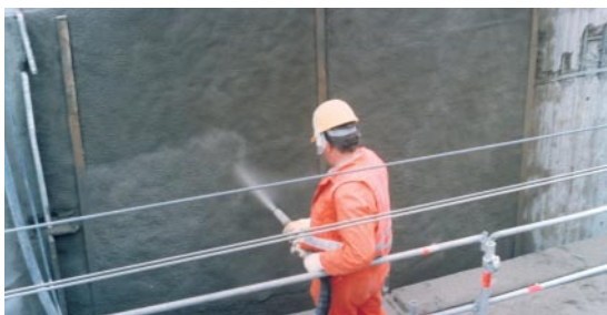
2. A betontakarás növelése.
