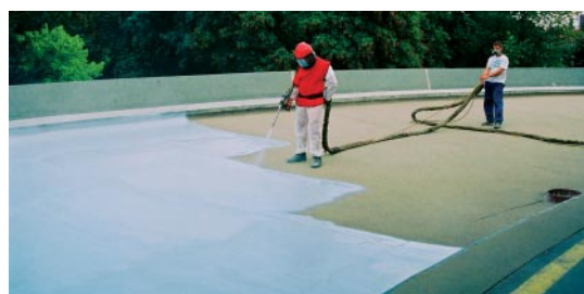
3. MC-Flex 2298 szigetelő réteg felvitele kétkomponenses szórásos eljárással.
