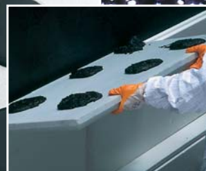
a szigetelés védelem felragasztása
