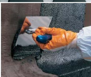
a szigetelés kézi felhordása
