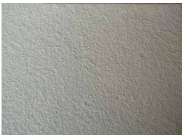
Szemcsehintéssel csúszásmentesített és fedőbevonattal ellátott padlóbevonat megjelenése
