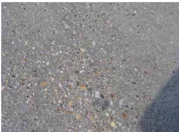
Megfelelően előkészített cement bázisu alap - felület
