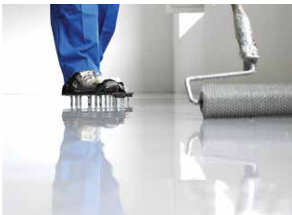
Öntött bevonat légtelenítése tűskés hengerrel
