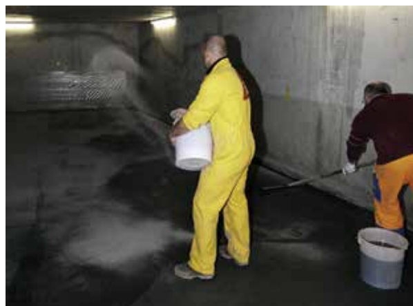
A bevonat csúszásmentesítése szemcsehintéssel
