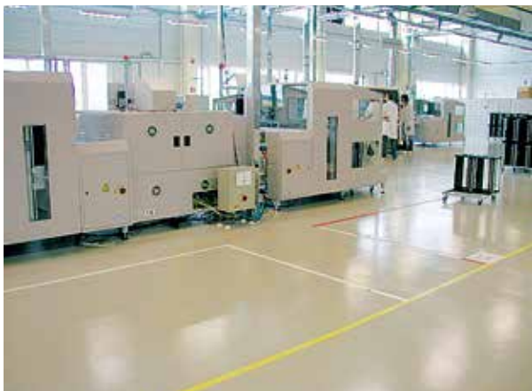
Ipari csarnok padlóbevonata Száras technológiájú helység, elektrosztatikus vezetőképeségi igény
